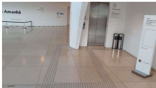
Imagem 4: Piso tátil sinalizando entrada do elevador Fonte: Acervo das autoras (2018)
